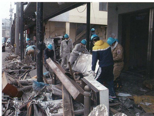
天理教岩手教区の災害救助隊による瓦礫の撤去作業
