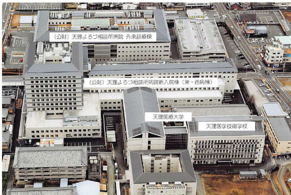
校舎と憩の家新入院棟 (東病棟・西病棟)・外来診療棟 (平成 25 年 12 月撮影)
