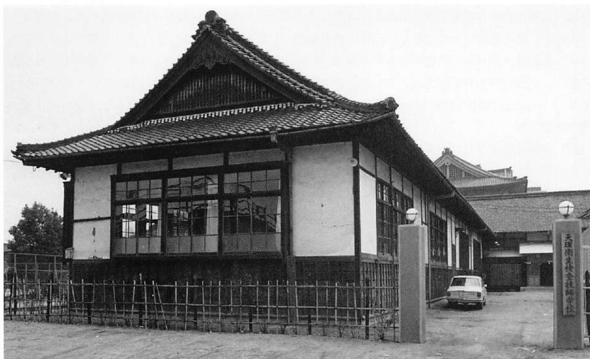
旧校舎（天理衛生検査技師学校）の正門付近
