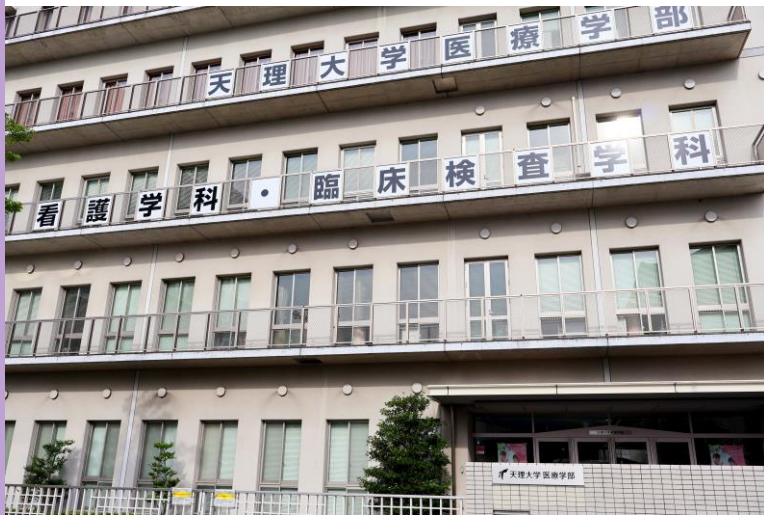
正門および玄関側（東側）からみた校舎
