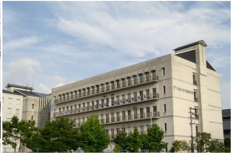
国道169号側（西側）からみた校舎
